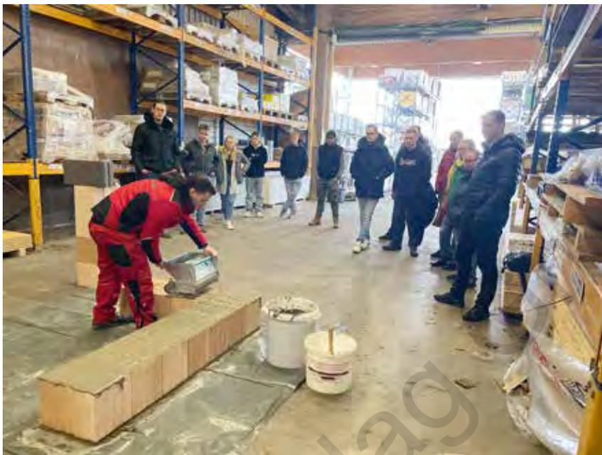
Vorführung des Mitarbeiters der Wienerberger GmbH: die Lagerfugen der Ziegel werden wie beim herkömmlichen Mörtel schichtweise durch die Dünnbettmörtelschicht vollflächig geschlossen.
